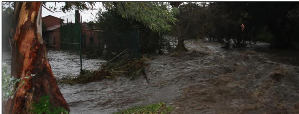
Figure 70 : Vue des débordements au niveau du club house de tennis
