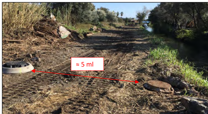
Figure 75 : Vue du réseau EU décalé en rive gauche
