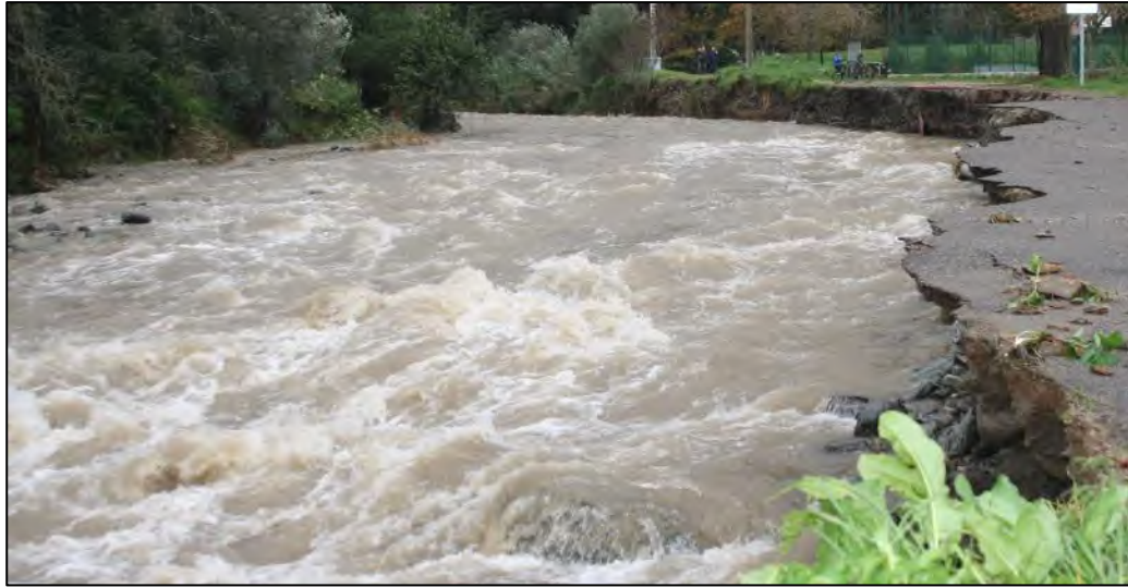
Figure 71 : Vue de l'érosion importante en rive gauche => effondrement de la route
