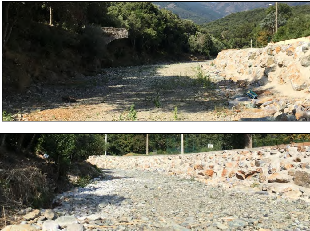
Figure 72 : Vues des travaux réalisées sur le ruisseau Poggiolo
